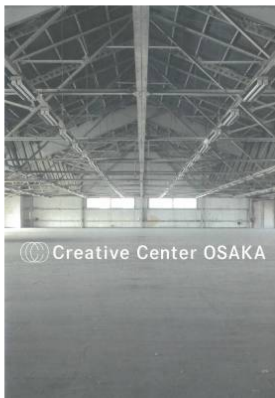
fig.造船所を改造した Creative Center Osaka
