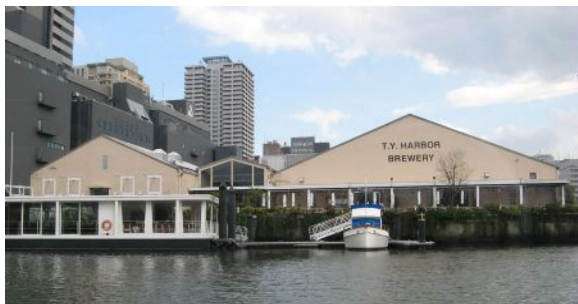
倉庫を活用したレストランと運河ルネサンスの第1号店としてオープンした水上ラウンジ (提供: 川添智史)
