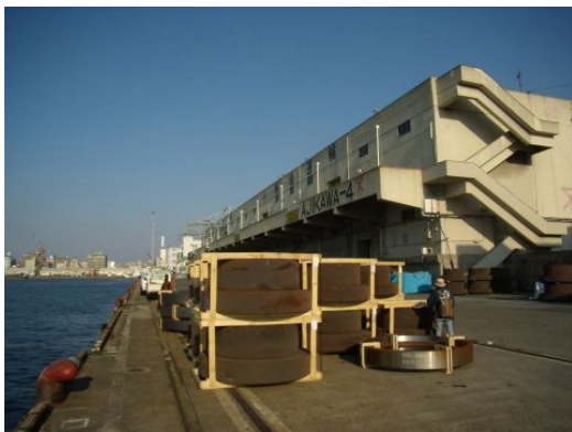
弁天ふ頭・安治川内港左岸の物流倉庫
