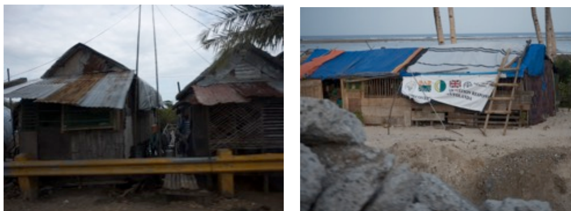
図5 東サマール地域の高速道路沿いの住宅(左)と仮設住宅(右)
